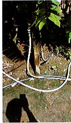
Photo 8 : Exemples de points d'eau tirés à partir de branchements de type spagettis
